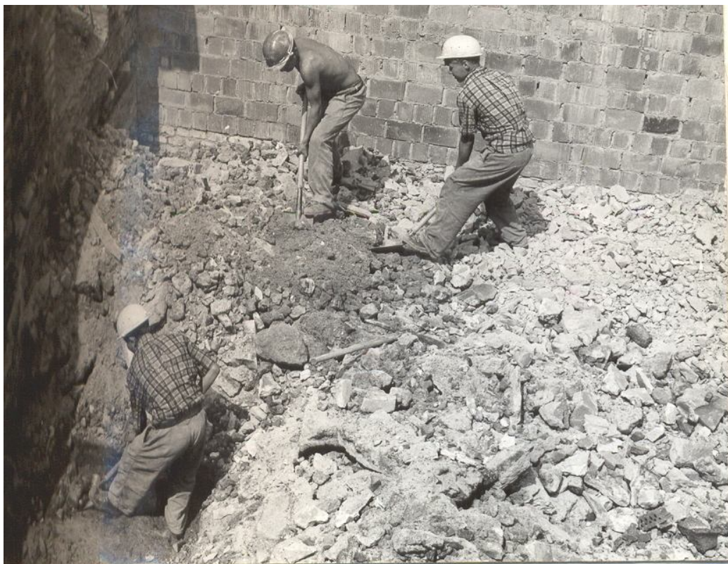
Ci wychowankowie w lipcu 1971 r. właściwie rozpoczęli ręcznie odgruzowywać piwnice Zamku. W tym przypadku urządzenia techniczne zawodziły.
