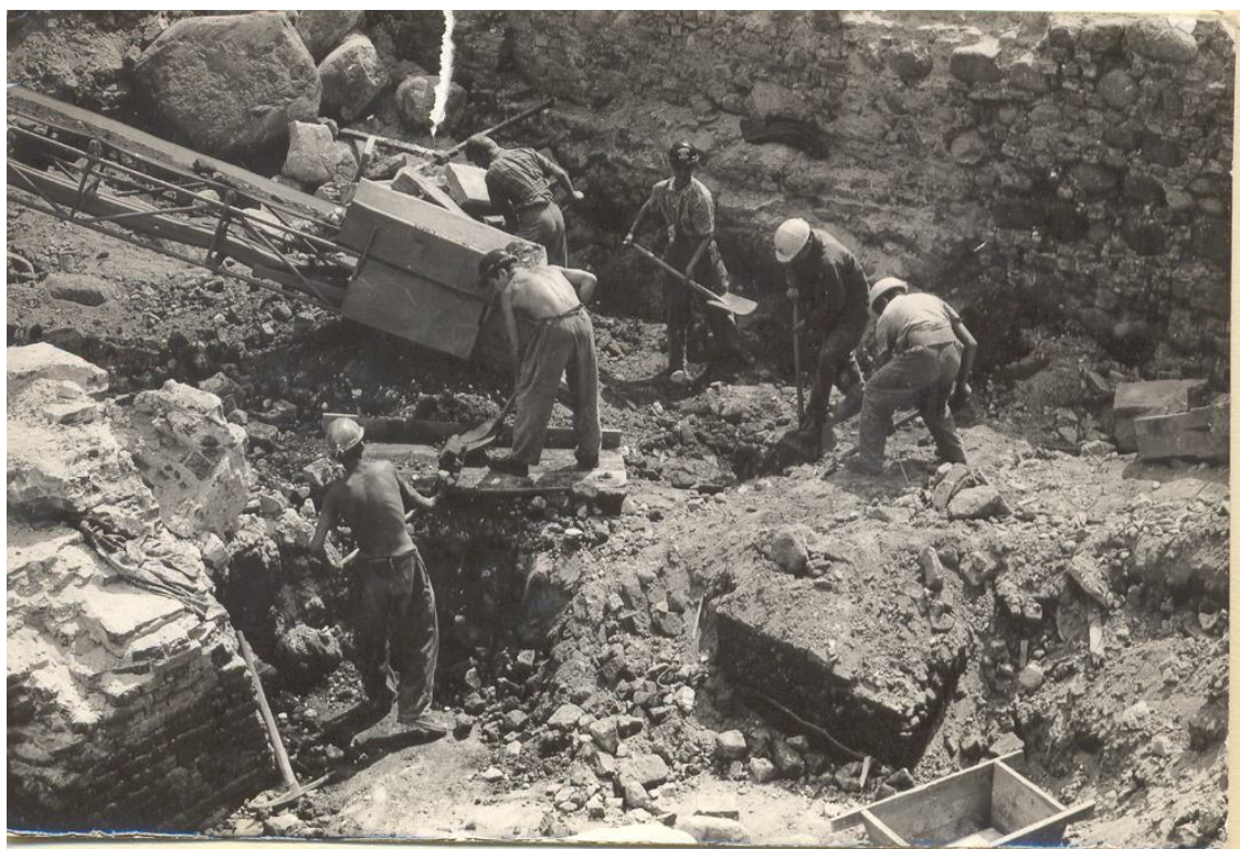
Przy pomocy taśmociągów wychowankowie usuwają gruz zбитy z piwnic przez lipiec i sierpień 1971 r. W tej pracy brało udział 120 wychowanków codziennie.
